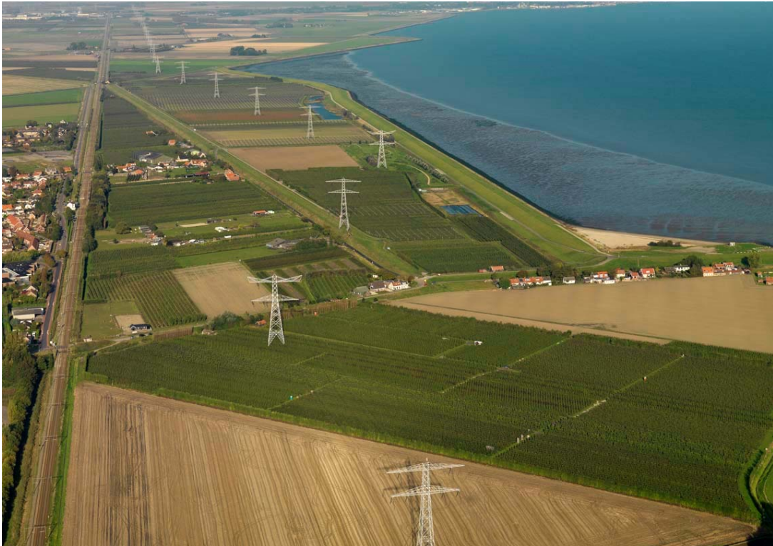
Foto 7 380kV-verbinding in de noordrand van Zuid-Beveland. Links de spoorlijn Bergen op Zoom - Goes met ten zuiden (links) daarvan Krabbendijke, rechts Nationaal Park Oosterschelde.
