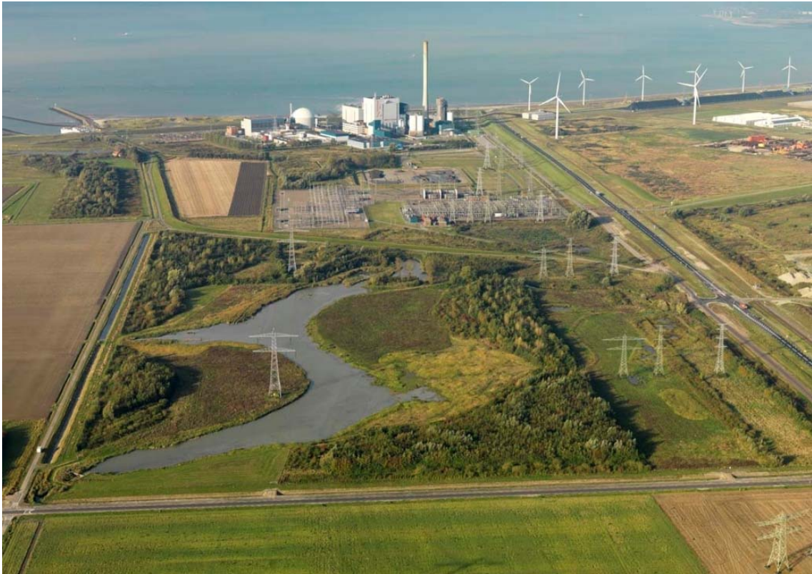
Foto 1 Het 380kV-station en het 150kV-station bij Borssele, Op de achtergrond de kerncentrale en de kolencentrale. Rechts het Sloegebied met windturbines en op de voorgrond groengebied 't Sloe doorsneden door een aantal hoogspanningsverbindingen.
