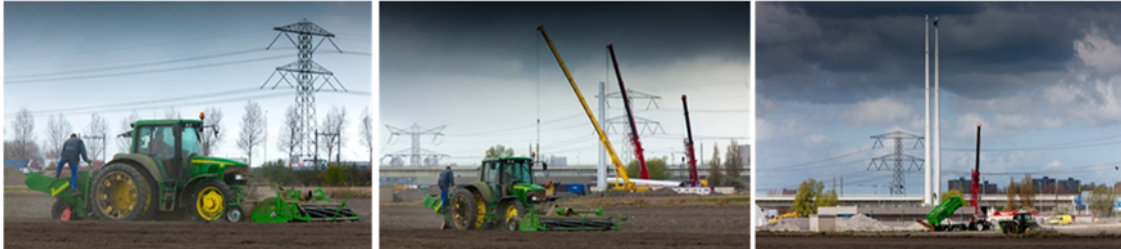
Afbeelding 10 Het bouwen van een mast
