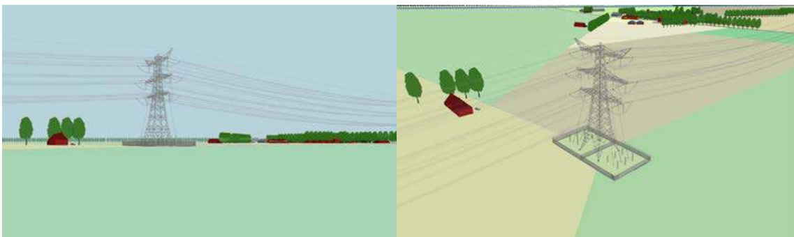
Figuur 3.5 Opstijgpunt van de 150 kV-verbinding
