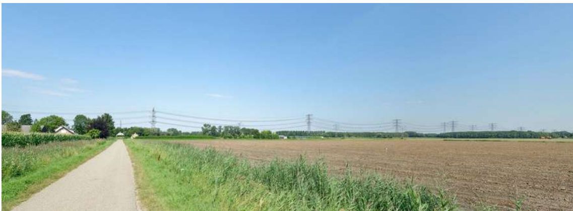
Beeld van de verbinding vanaf de Galgenweg in Zevenbergen in noordelijke richting
