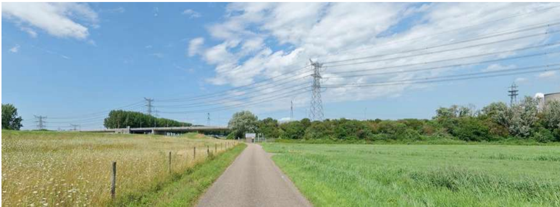
De kruising met het Amerkanaal vanaf de Brandweg
