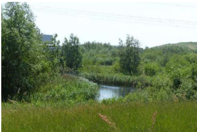
Foto 13 Effluentvijver van waterzuiveringsinstallatie
