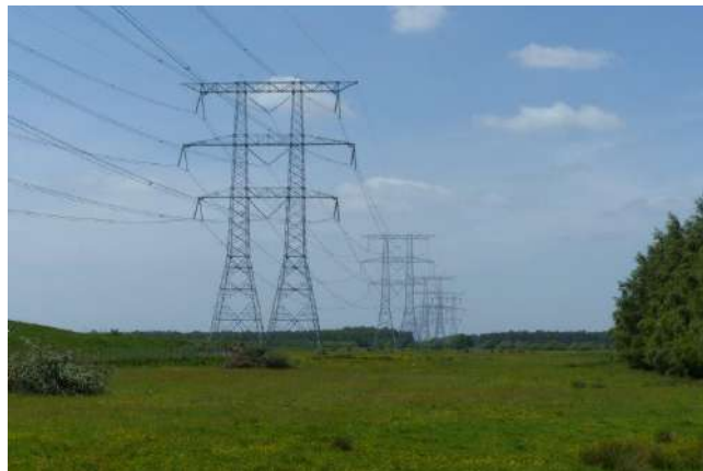
Foto 14 Bestaande, te amoveren 380 kV leiding ten zuiden van het onderzoeksgebied
