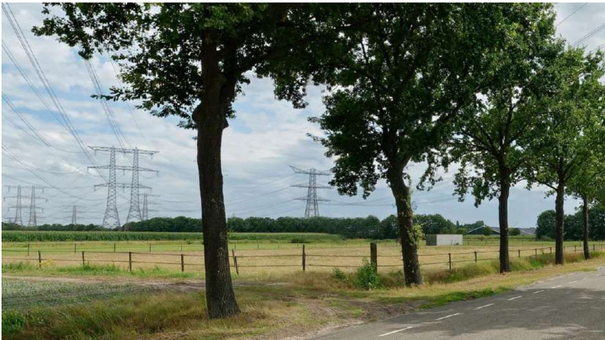
Afbeelding 6b Foto montage met Moldau combimast (rechts) en de bestaande 380kV mast Geertruidenberg-Eindhoven (links)
