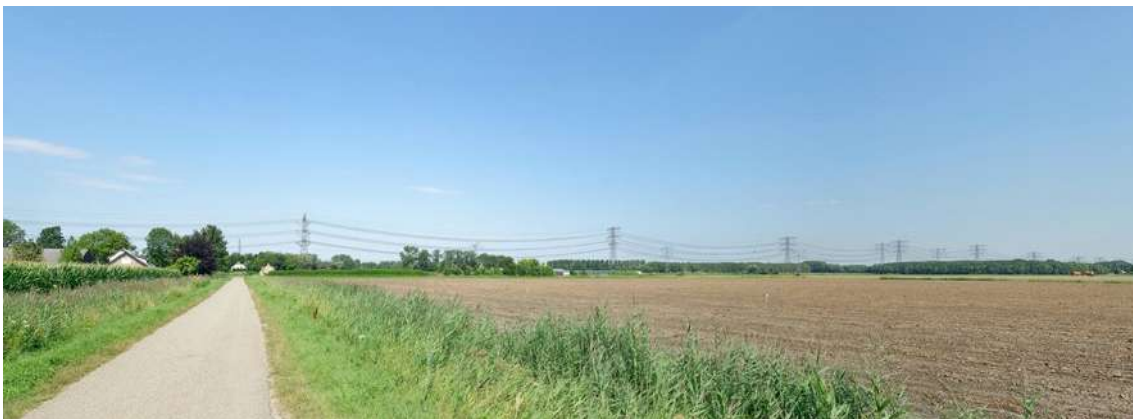
Beeld van de verbinding vanaf de Galgenweg in Zevenbergen in noordelijke richting
