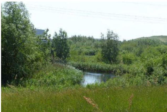
Foto 13 Effluentvijver van waterzuiveringsinstallatie
