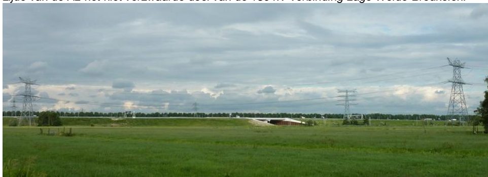
B2.7c. Zicht uit het noorden over de mogelijke stationslocatie naar de verhoogde A2 met de onderdoorgang van het spoor Breukelen-Woerden. Helemaal links en rechts de masten 105 en 104 van de 380 kV-verbinding Diemen-Krimpen. Aan de oostzijde van de A2, de masten 28, 27 en 26N (vier traversen) in de verzwaarde 150 kV-verbinding Lage Weide-Breukelen. Vergelijk de simulatie B2.2a.
