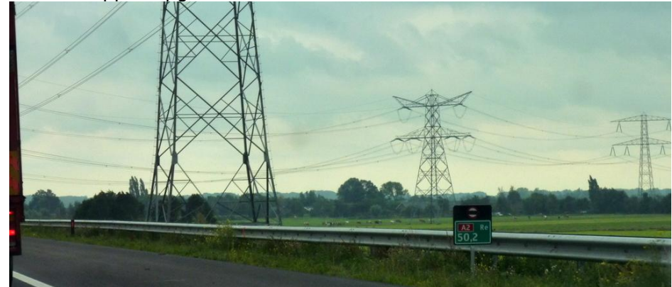
B2.7b. Zicht vanaf de A2 in zuidelijke richting bij Kortrijk, met van links naar rechts de masten 106, 104 en 103 van de 380 kV-verbinding Diemen-Krimpen; mast 105 is links juist buiten beeld. Vergelijk ook B2.7d en de simulatie B2.3a.
