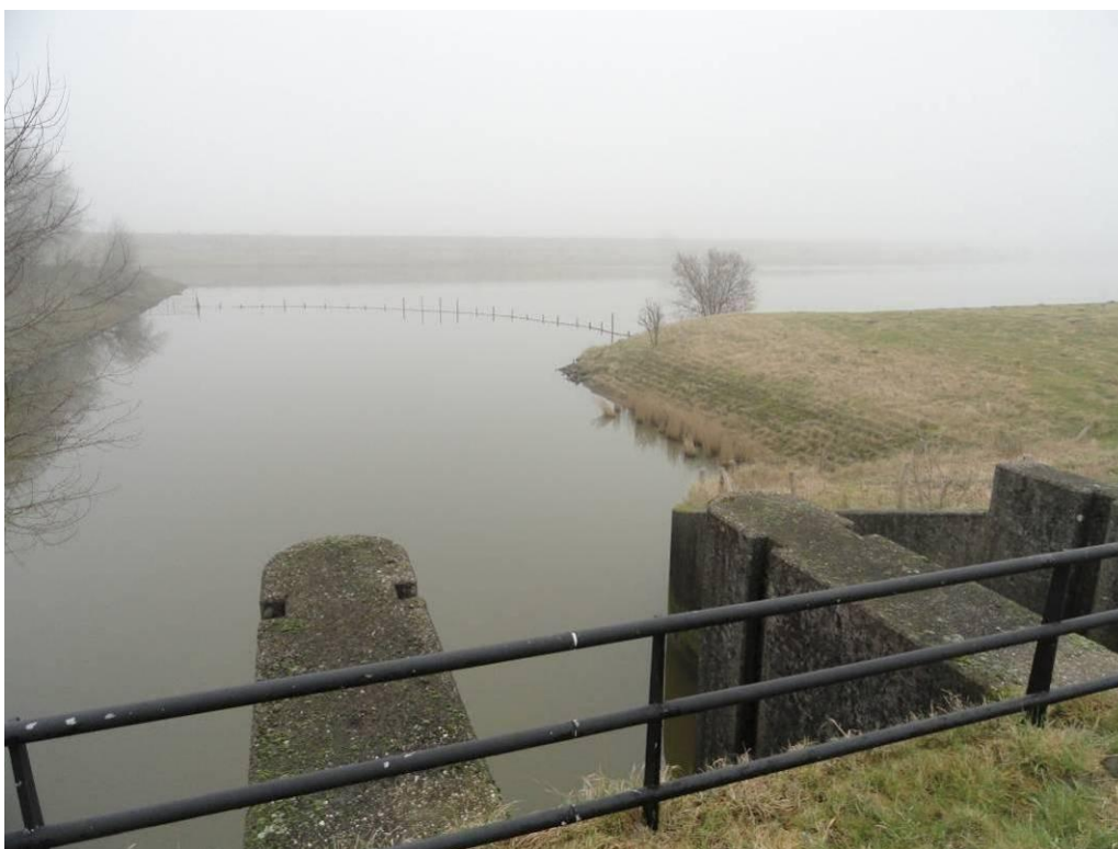
Figuur 4.3 Spuikom gezien vanaf spuisluis
