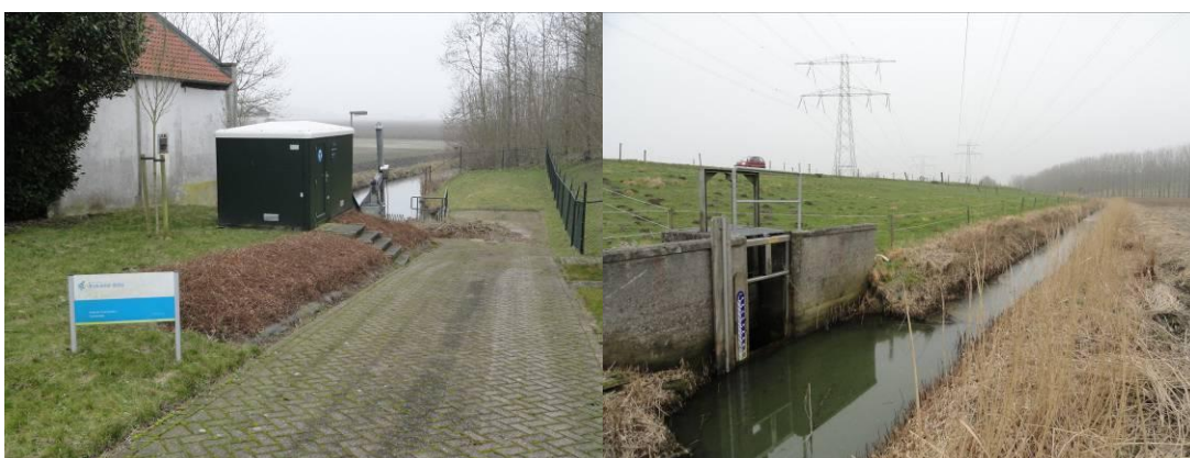
Figuur 7.2 Gemaal Toerenpolder (links), duiker met stuw onder Dikkendijk (rechts)
