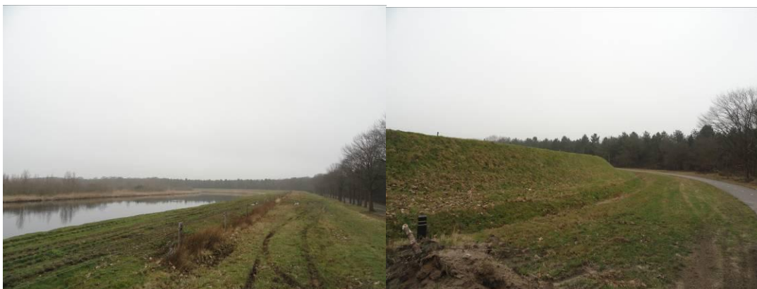
Figuur 5.4 Dijk langs effluentvijver RWZI Tilburg. Links is de effluentvijver zichtbaar vanaf de dijk, rechts is de dijk zichtbaar vanaf het omliggende gebied.
