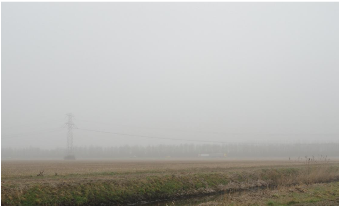
Figuur 4.1 Huidige situatie 380 kV station Rilland
