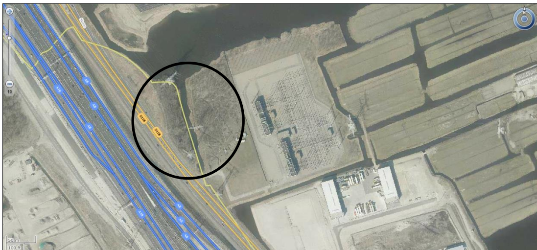
figuur 1: Overzicht plangebied project "Uitbreiding 380kV- station OZN380 Oostzaan".
