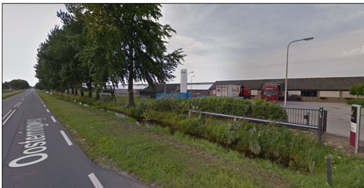
Afbeelding 12: Bestaande bebouwing aan de Oosterringweg (bron afbeelding: Google Maps, streetview)
