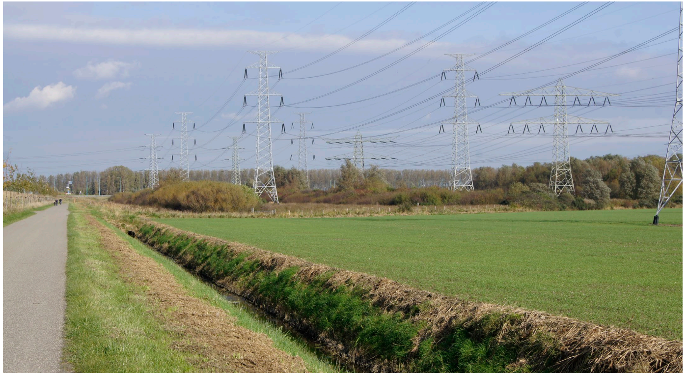
Figuur 14 Locatie kabeltracé door Groenproject 't Sloe (locatie 3) met helemaal links de uit bedrijf zijnde 150kV klantverbinding die vanaf 2021 en deels vanaf 2023 in het kader van Net op zee IJmuiden Ver Alpha zal worden verwijderd
