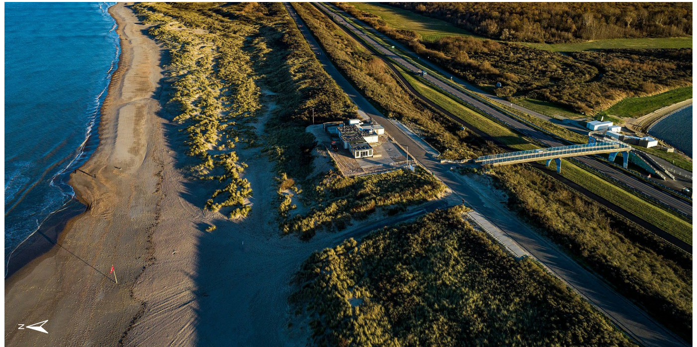
Figuur 5 Dronefoto met zicht op de locatie van het tijdelijke werkterrein aan de noordzijde van de Veerse Gatdam (links op het strand)
