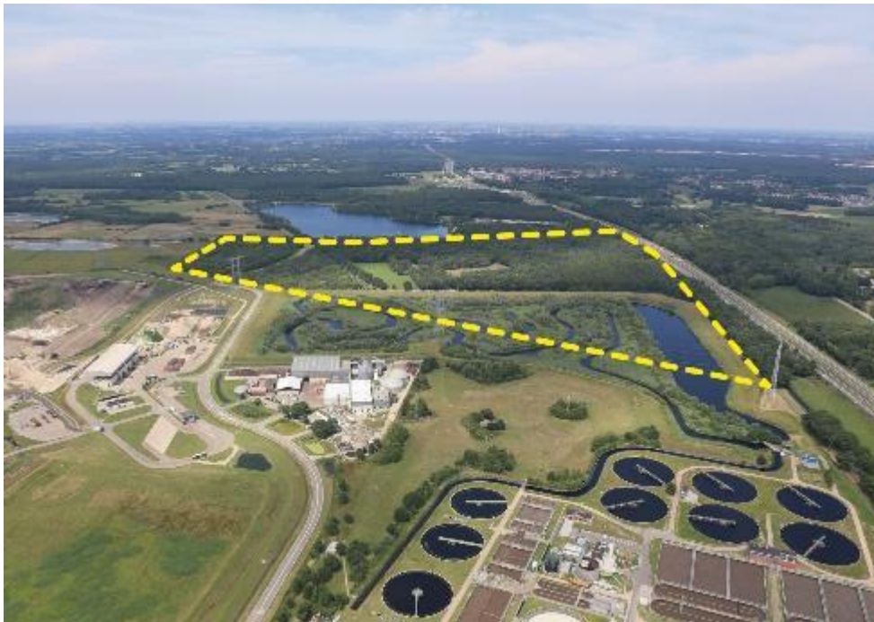
Figuur 2.9 Luchtfoto stationslocatie De Spinder
