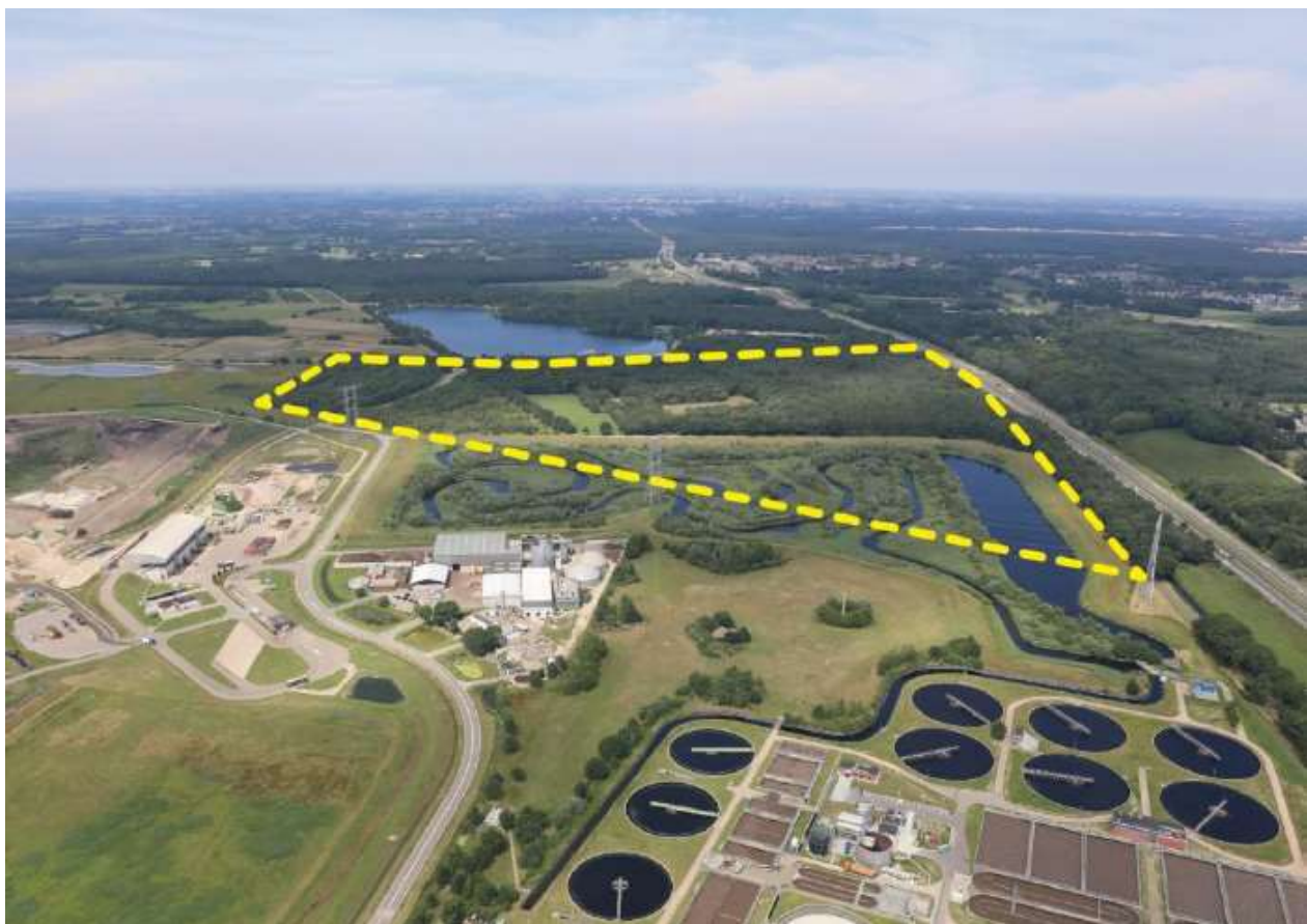
Figuur 6: luchtfoto hoogspanningsstation locatie de Spinder
