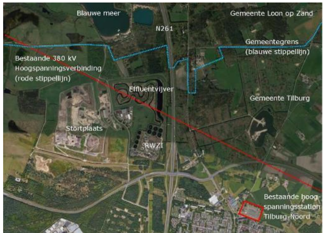
Figuur 2.12 Luchtfoto bestaande situatie plangebied en omgeving
