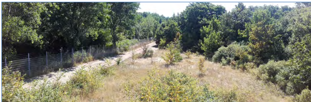
Figuur 12. Impressie van deelgebied 8 Transformatorstation (Tata Steel) ter hoogte van boring 71. Kijkrichting is naar het oosten.
