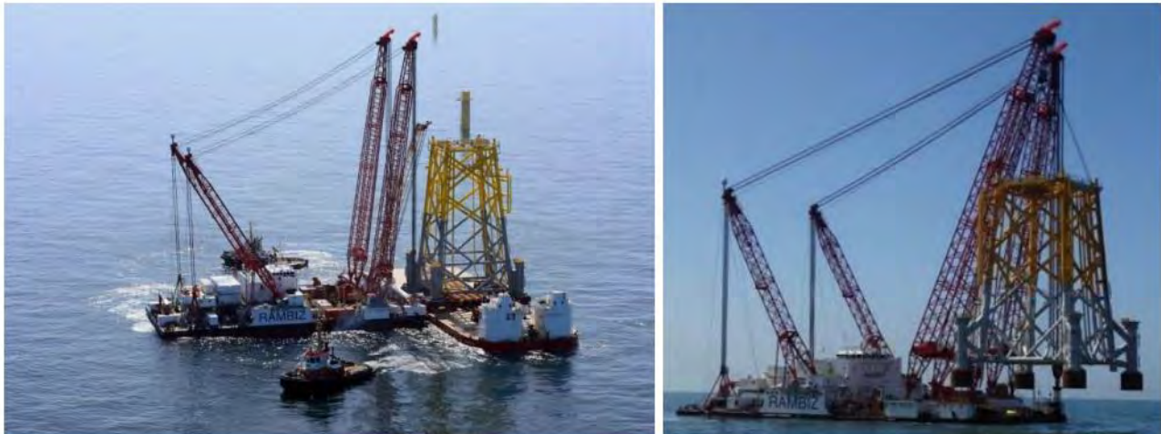
Figuur 5: Impressie van het plaatsen van het jacket.
