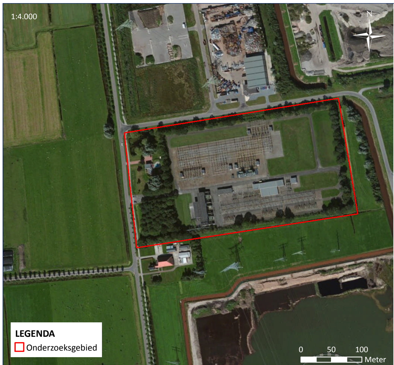
Figuur 2: Het onderzoeksgebied “Onderstation aan De Dolten 7 te Heerenveen (Oudehaske)”. Verwerking in ArcMap 10.2.
