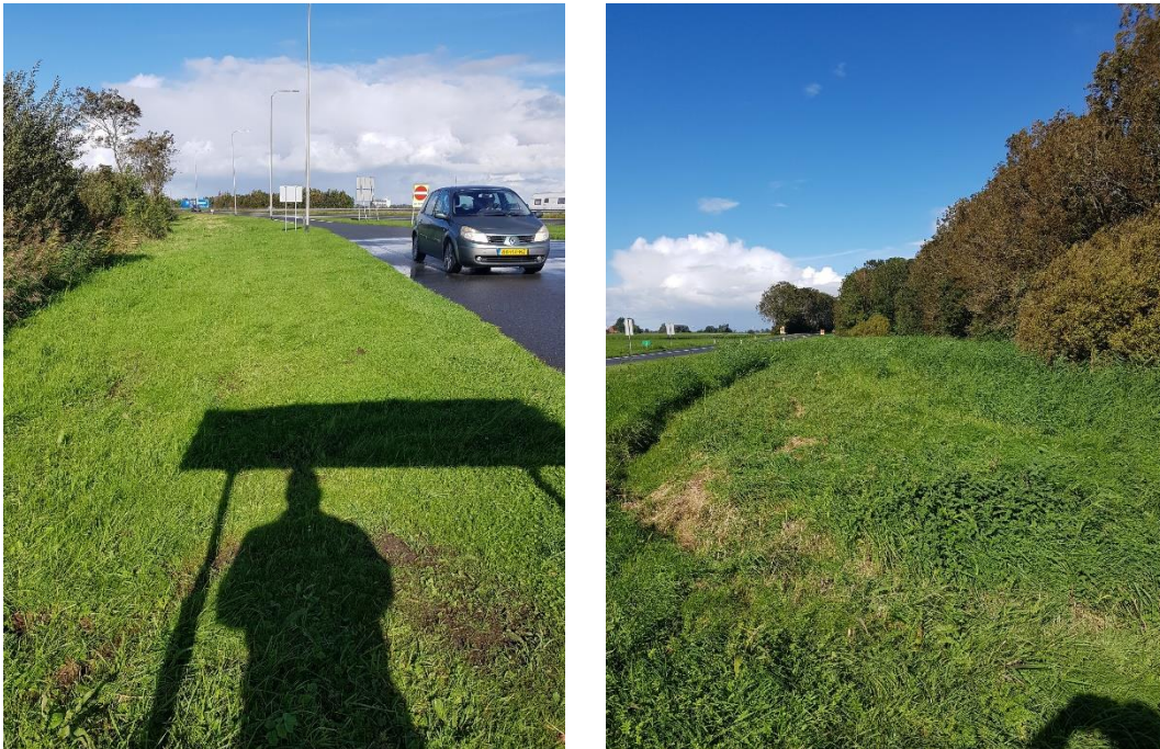
Figuur 2 Links een foto bij de afrit van een tankstation langs de A7 met het uitzicht op de berm waar een lasput / mof-locatie is gelegen. Rechts een foto aan de onderzijde van een talud. Hier is duidelijk de verruiging zichtbaar met voornamelijk veel Grote brandnetel.
