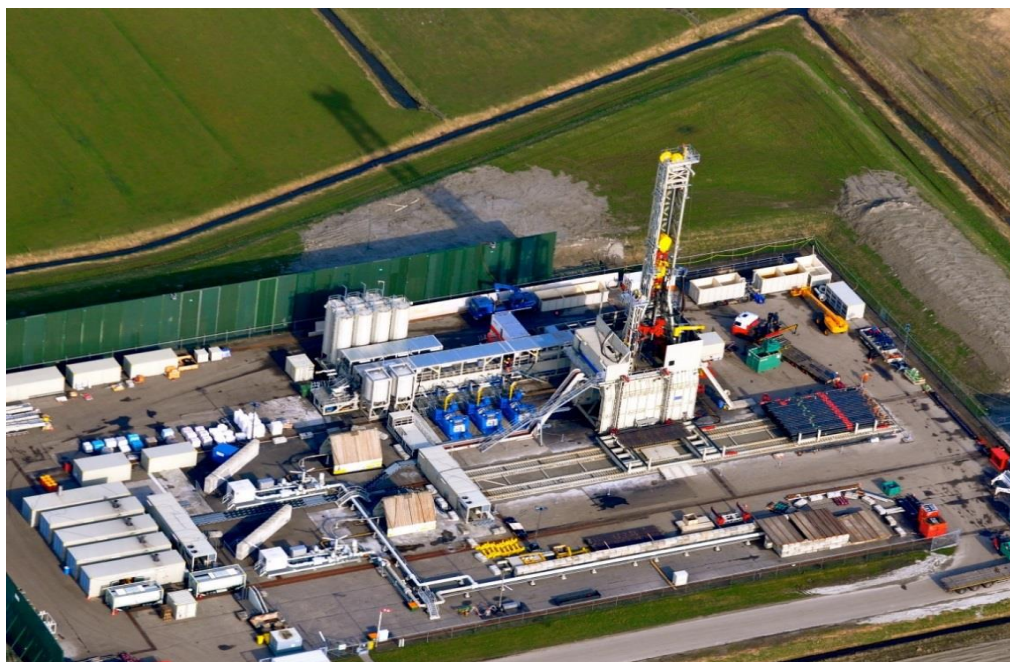
Figuur 2.2 Boorinstallatie inclusief boortoren en geluidswanden (bron: MER Gasboring en gaswinning Ternaard)
