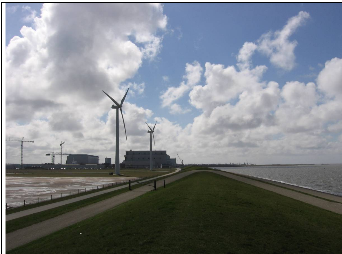
Bedrijventerrein Harlingen; masthoogte 50 meter, tiphoogte 78 meter
