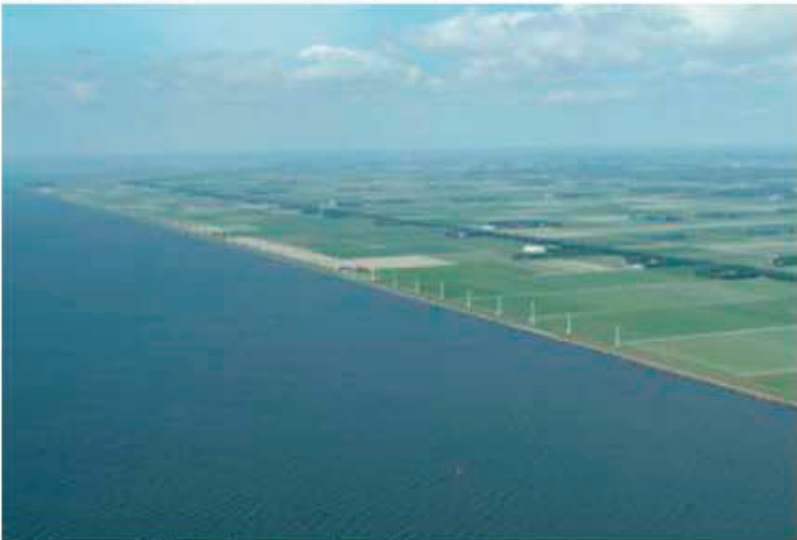
Zuidermeerdijk met bestaande turbines
