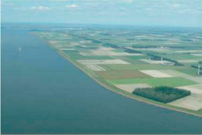
Westermeerdijk met bestaande opstelling
