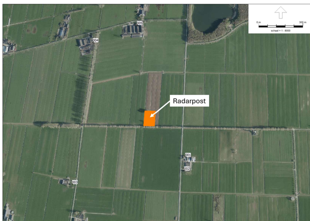
f 2.1 Situatie van de radarpost Herwijnen
