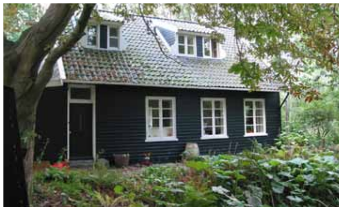
houten Verboden Kringenwetwoning
