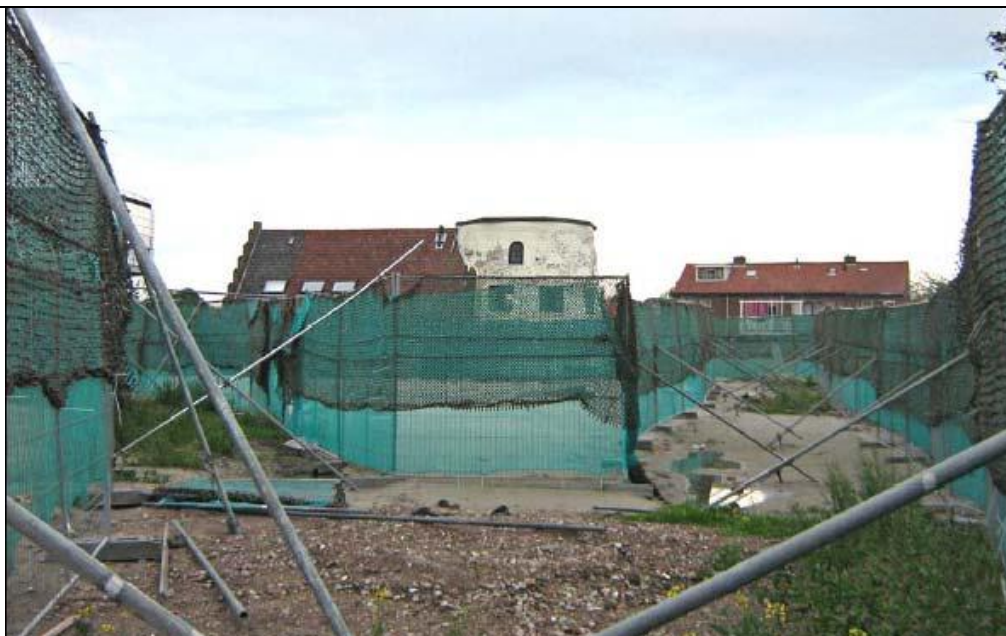
Figuur 3.13 Hekwerk waarmee vliegroutes van watervleermuis en gewone dwergvleermuis behouden blijft (Koelman, 2008).
