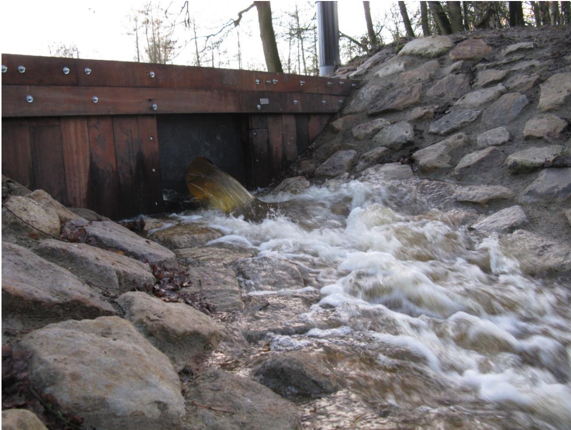
Foto's knijpconstructie retentie Roderveld. In deze memo wordt eenzelfde soort constructie aangeraden, zij het met afwijkende afmetingen
