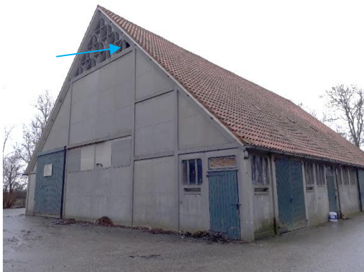
Schuur (g8-2) met toegang voor fauna (blauwe pijl)
