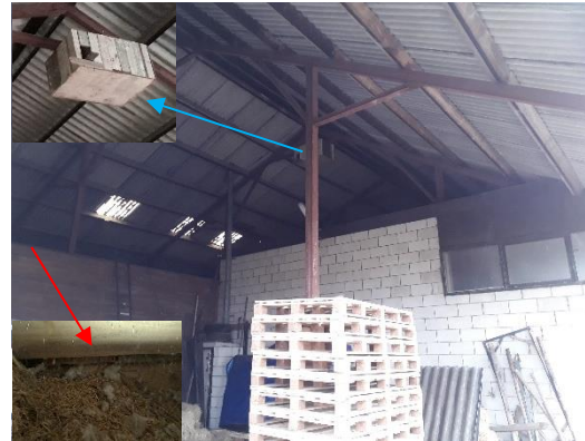
Achterzijde schuur (g8-3) met halfopen kap kerkuilenkast aan de binnenzijde (blauwe pijl) en potentieel steenuilennest onder de vloer (rode pijl)
