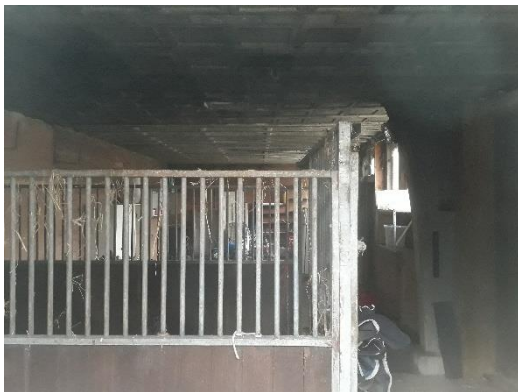
Binnenzijde schuur (g8-2)
