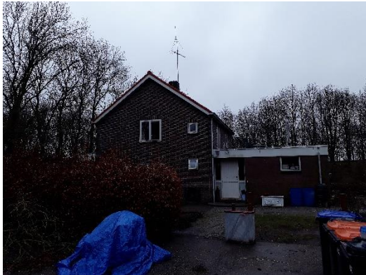
Woning (g4-1) met potentiële verblijfplaatsen onder dakrand en spouwmuur en zoldervloer
