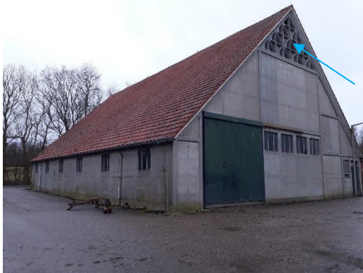
Schuur (g4-4) met toegang voor fauna (blauwe pijl)
