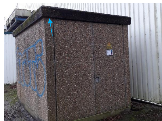
Transformatorgebouw (g4-3) met een potentiële vleermuis zomer- en paarverblijfplaats voor (blauwe pijl)
