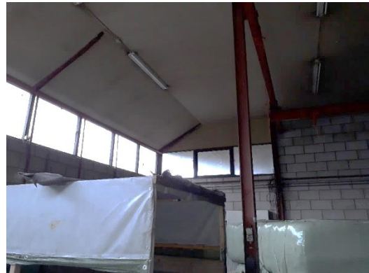
Binnenzijde schuur (g8-2), geen toegang voor fauna
