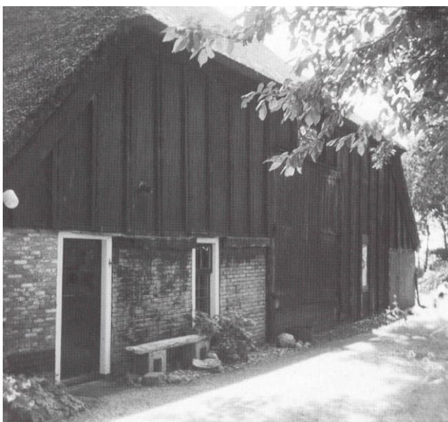
Figuur 3: de houten geteerde achtergevel van een Wieringerboerderij (bron: Historische Vereniging Wieringen, 2003)
