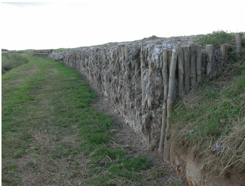
Figuur 5: opstelling dijkopbouw aan de Wierdijk.
