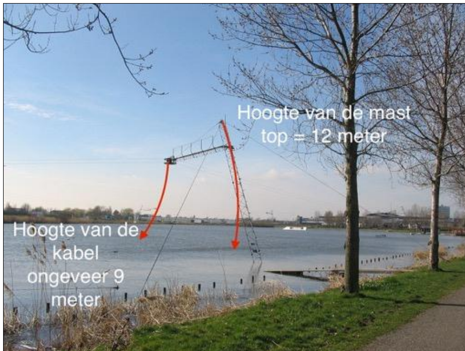
Figuur 4. De standaardpaal van 12 meter (let op de rode lijnen geven slechts de maathoogten aan)
