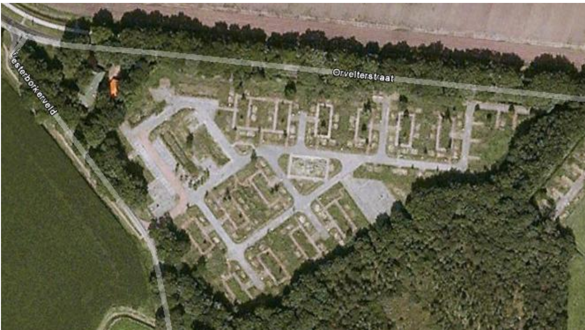
Afbeelding 1: bestaande situatie AZC-terrein
