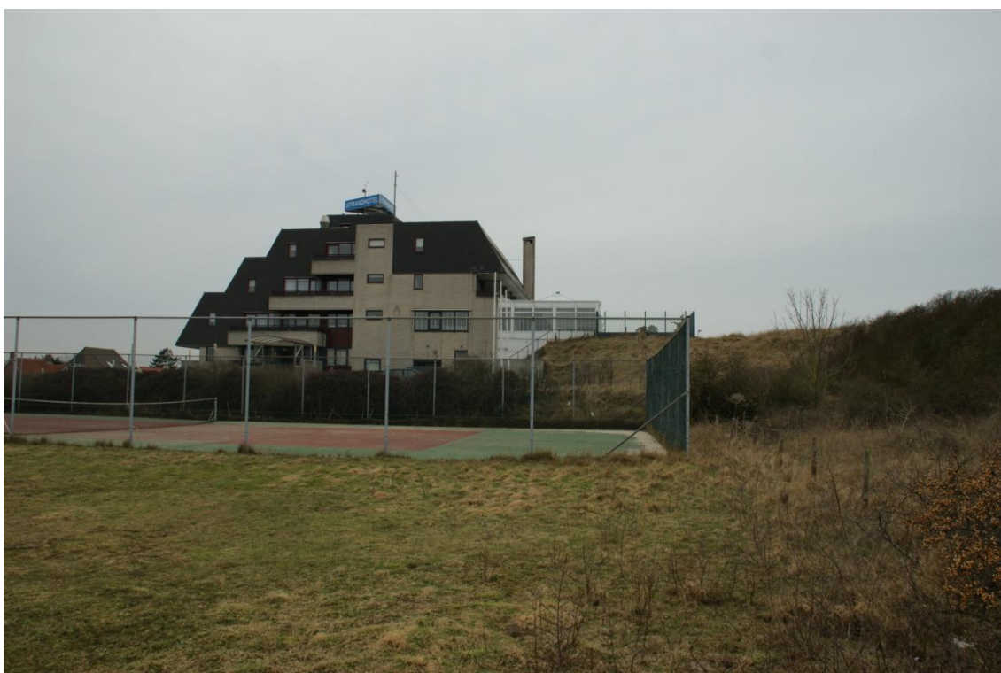
Figuur 2.5. Huidig Strandhotel (gladde afwerking dak en buitenmuur, ongeschikt voor vlermuizen)
