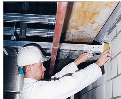
Brandveiligheidsprofessional bezig met het afdichten van een kabelgoot doorvoering
