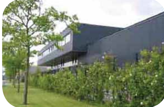
bedrijfshal met kantooropbouw
