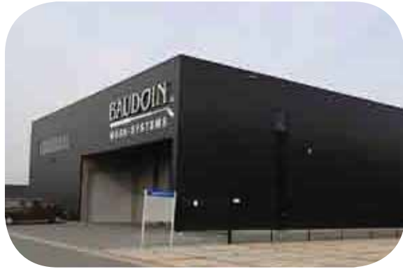
open gevel bij entree
