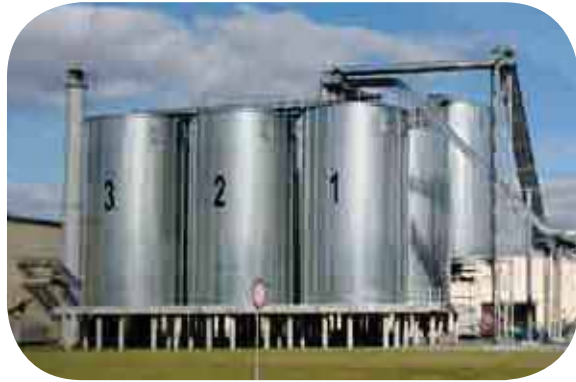
silos en bedrijfsinstallaties
