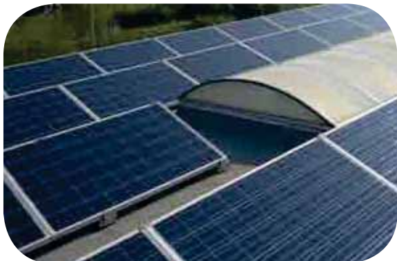
duurzame energie opwekking - zonnepanelen
