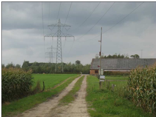
Hoogspanningsverbinding binnen het plangebied.
