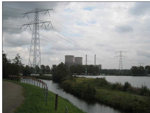
Hoogspanningsverbinding aan de rand van het plangebied, met zicht op de Clauscentrale.
