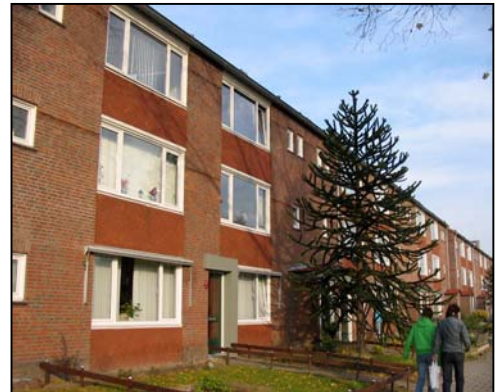
boven- en benedenwoningen
