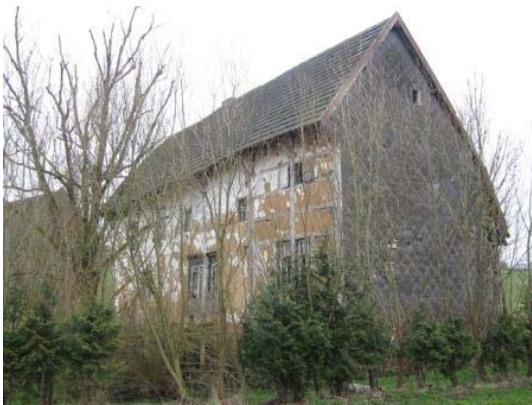
Figuur 3: Het vervallen voormalige woonhuis.
