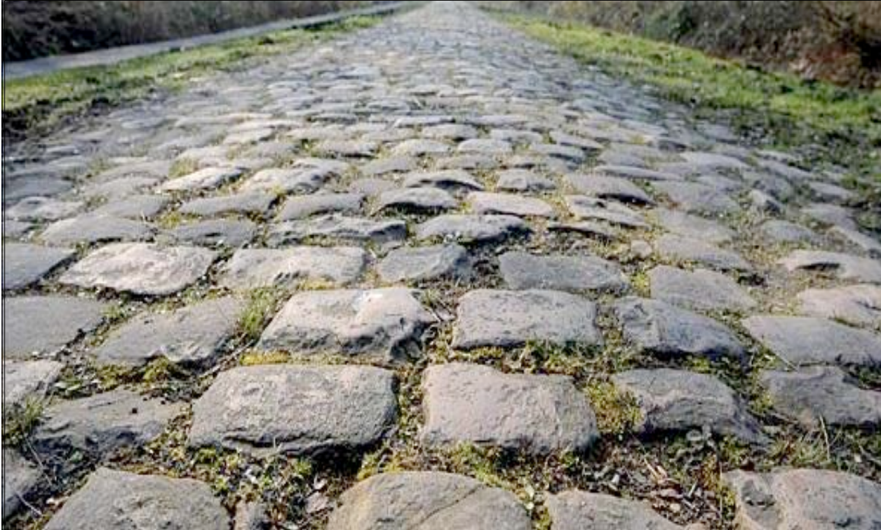
half open verharding met afwijkend patroon tbv. aanduiding autoroute. type: zoals kessein (kinderkopijes) of soortgelijke natuursteenen met voegen tbv infiltratie regenwater
