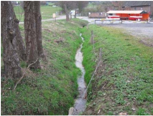
Figuur 7: De Camerigerbeek langs de verharde weg aan de noordzijde van het onderzoeksgebied.
