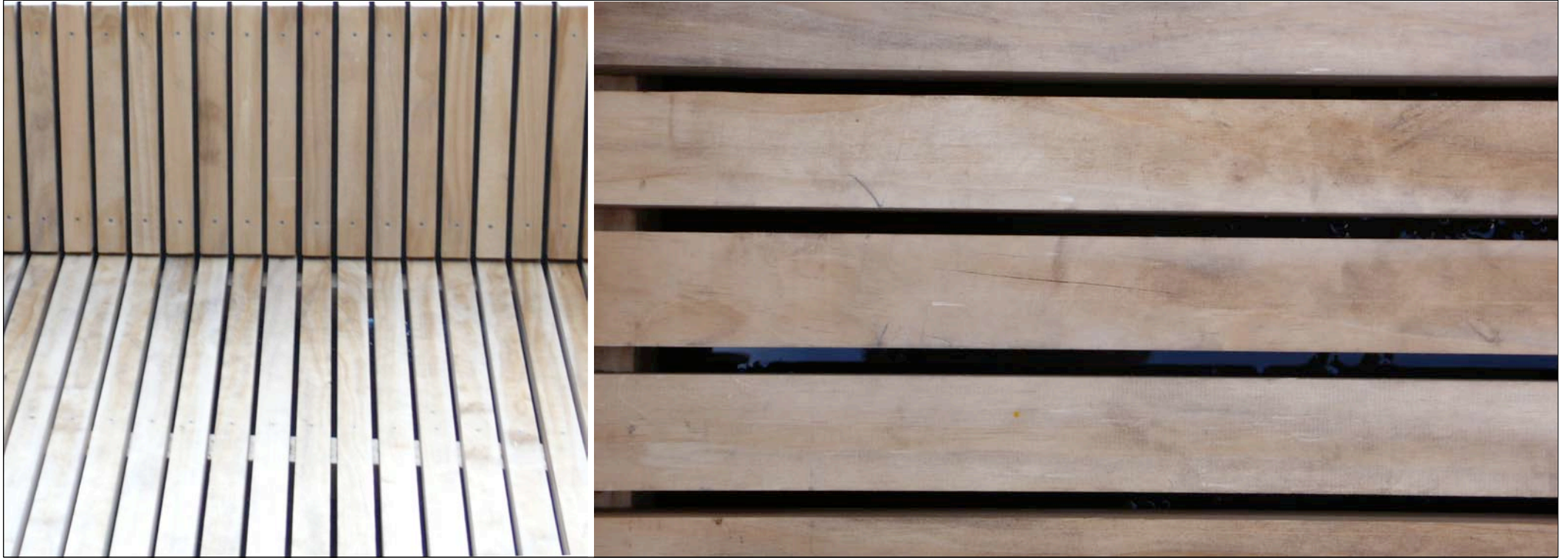
brug oversteekplaats en balustrade in hout
