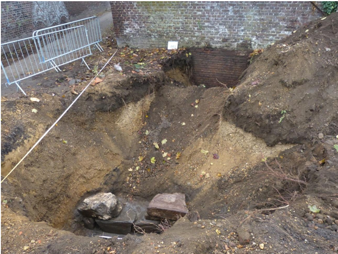
Afbeelding 36: Sleuf 3, overzicht. Goed te zien is het ophoogpakket bestaande uit grof grind, waardoor de wanden pas enigszins stabiel bleven bij een helling van circa 45°. Het middelste deel van de put is hier al weer deels dichtgestort met grond afkomstig van het vrij graven van de stenen op de voorgrond.
