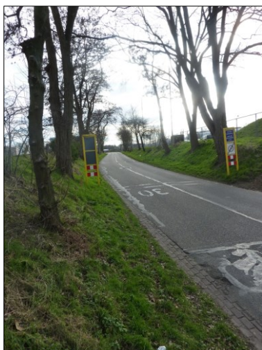
Afbeelding 14: Schepersweg in oostelijke richting van plangebied
