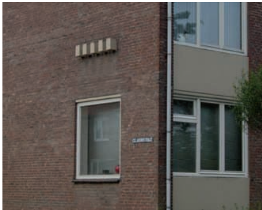
Kopgevel met herhalend detail, Pottenberg
