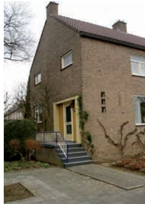
Bordes vangt niveaoverschillen op, Malpertuis
