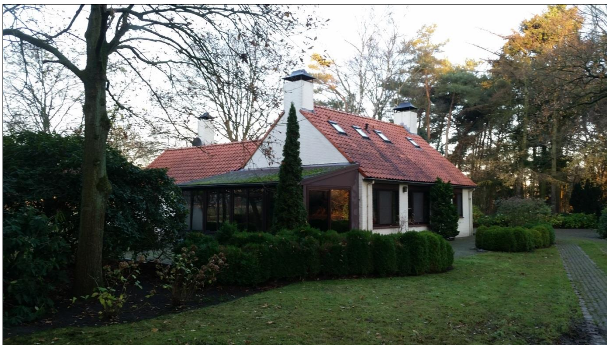
Foto 1. Onderzoekslocatie met te slopen woning
