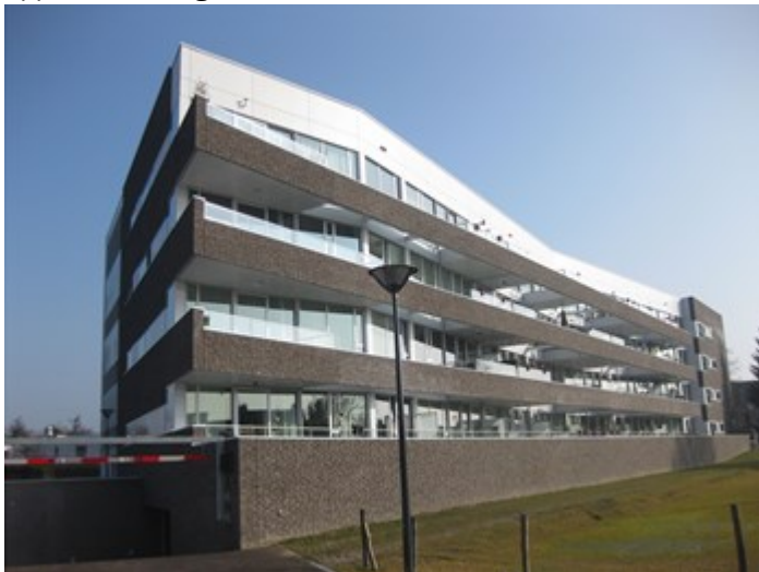
Appartementengebouw ten oosten van besluitgebied
