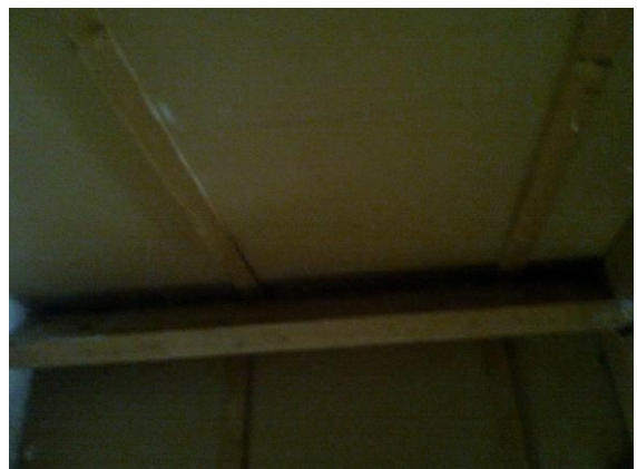
Beschot binnenzijde dak (zolder), woonhuis Dijkstraat 4.
