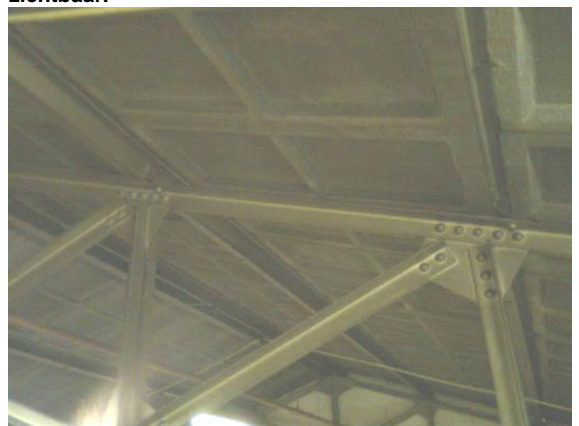
Binnenzijde dak, betonplaten.
