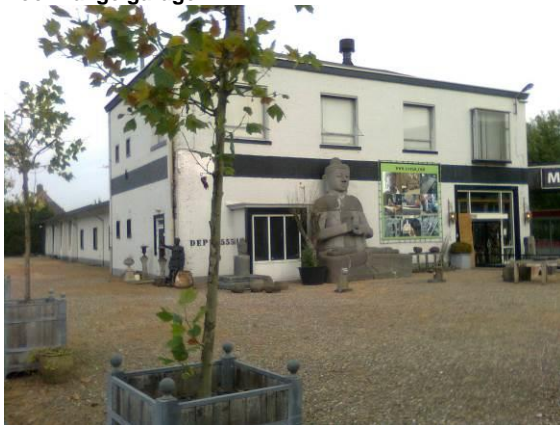
Voorkant voormalige garage. Op alle hoekpunten is een lamp aanwezig.
