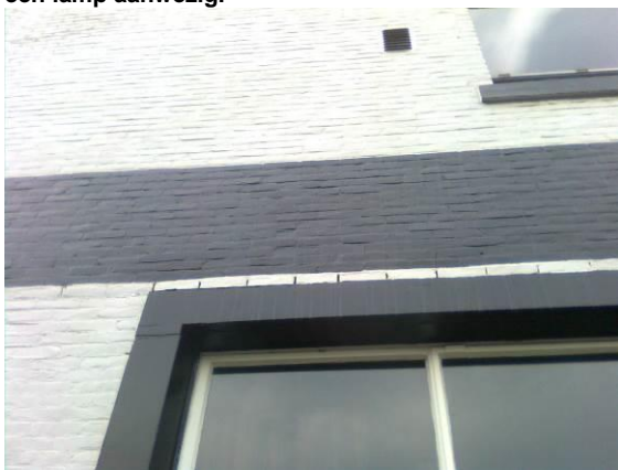
Stootvoegen boven raam in voormalige garage (deel met 2 verdiepingen).
