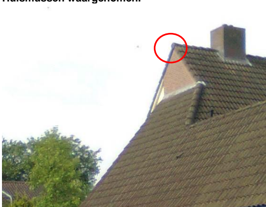
Dicht dakpannendak op woonhuis Dijkstraat 4. Toegang tot dak in nok.
