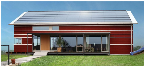
Voorbeeld van geïntegreerde zonnepanelen
