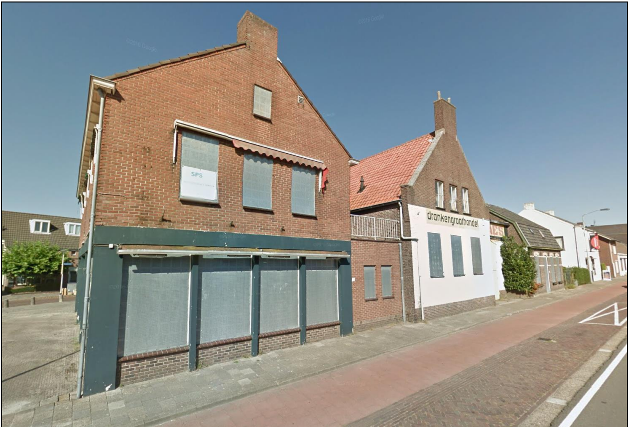
Figuur 2: Streetview van het plangebied Dommelseweg 112-118. Huisnummer 118 is links in beeld (hoekpand), daarnaast nummer 116, 114 en rechts in beeld (witte gevel) nummer 112. Bron: Google Maps.
