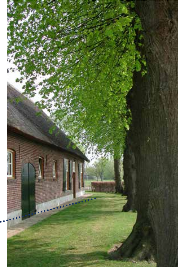
Klinkerrand en linde bij schuur
