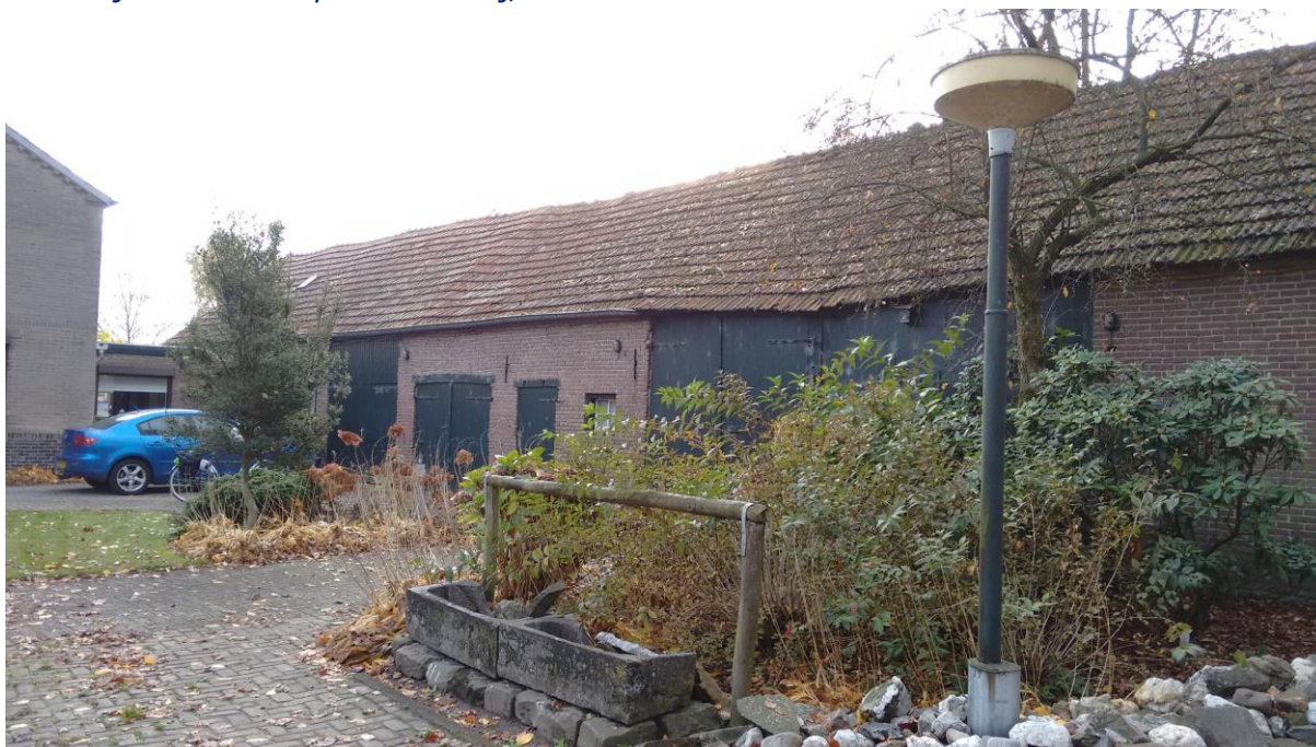
Noordzijde van te slopen boerderij/schuur met woonhuis:
