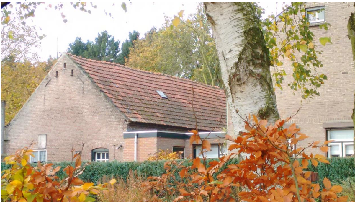
Oostzijde van te slopen boerderij/schuur met woonhuis:
