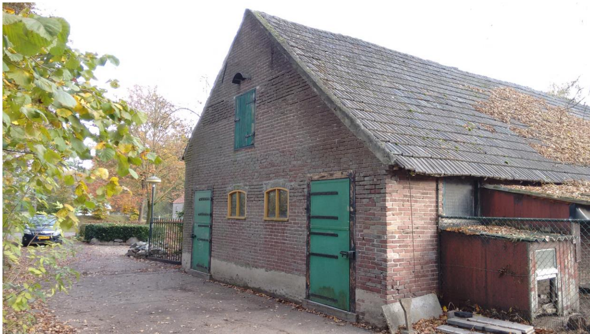
Westzijde van te slopen boerderij/schuur:
