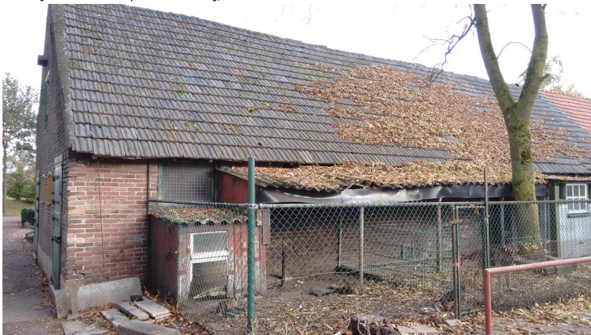
Zuidzijde van te slopen boerderij/schuur:
