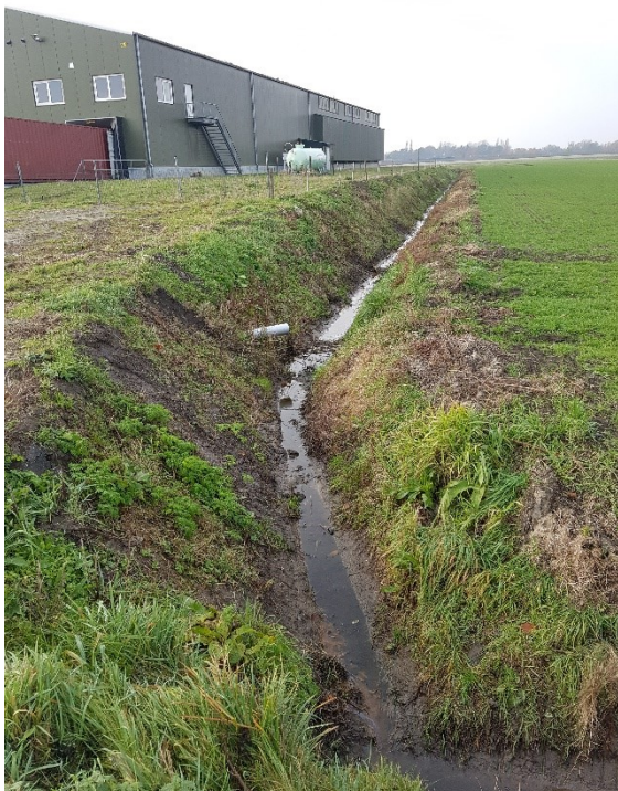
De door de eigenaar zelf gegraven geul die zal worden gedempt.
