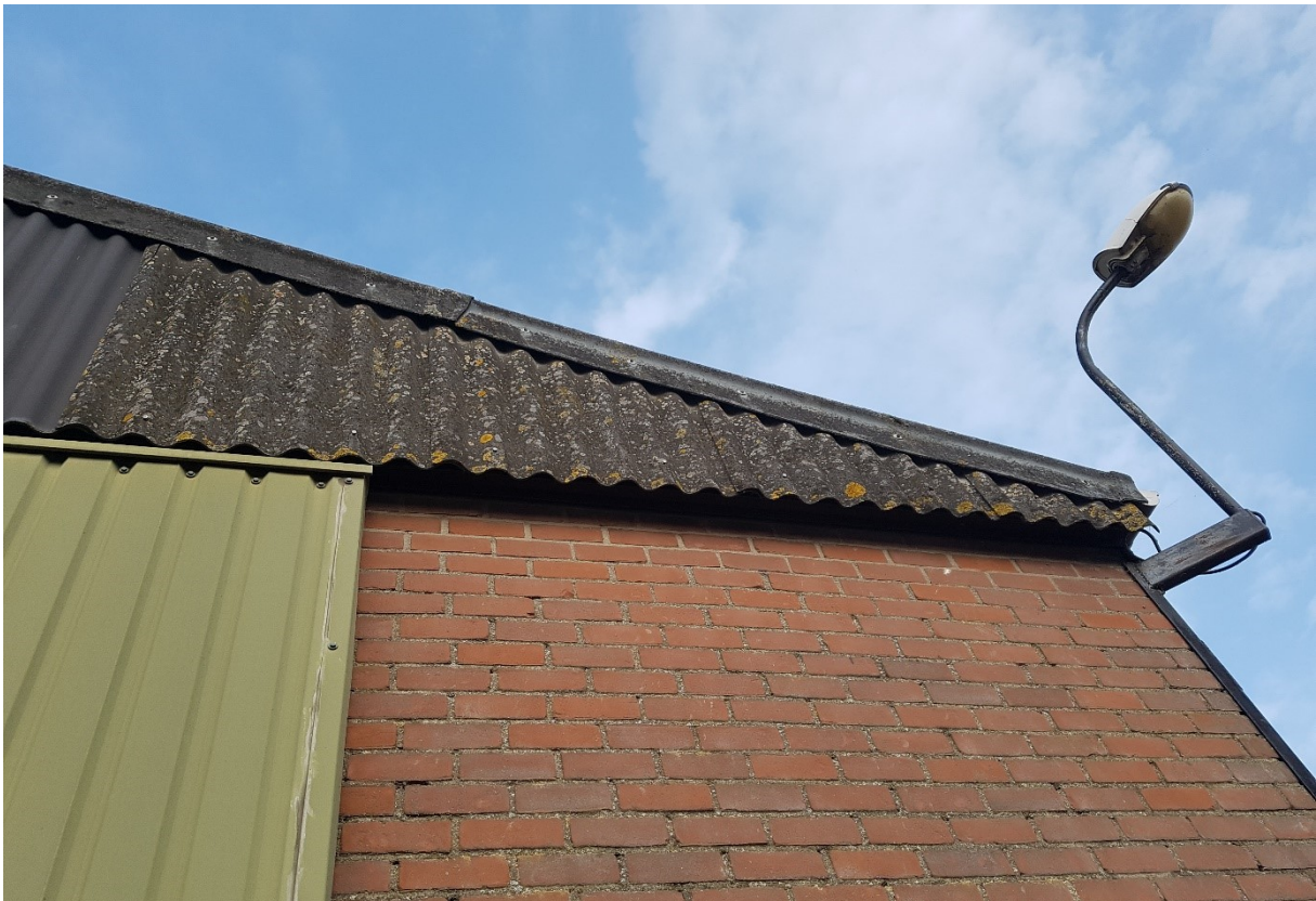
De asbestgolfplaten bieden geen toegang tot de loods en zijn voor vleermuizen oninteressant.
