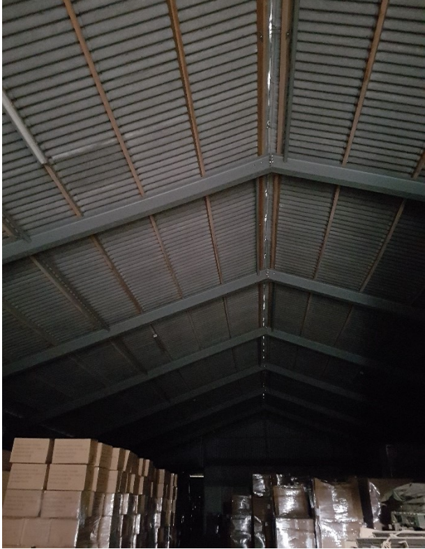
De vierde loods is door de bouwstijl en het ontbreken van isolatie en warmtebronnen ongeschikt voor vleermuizen
