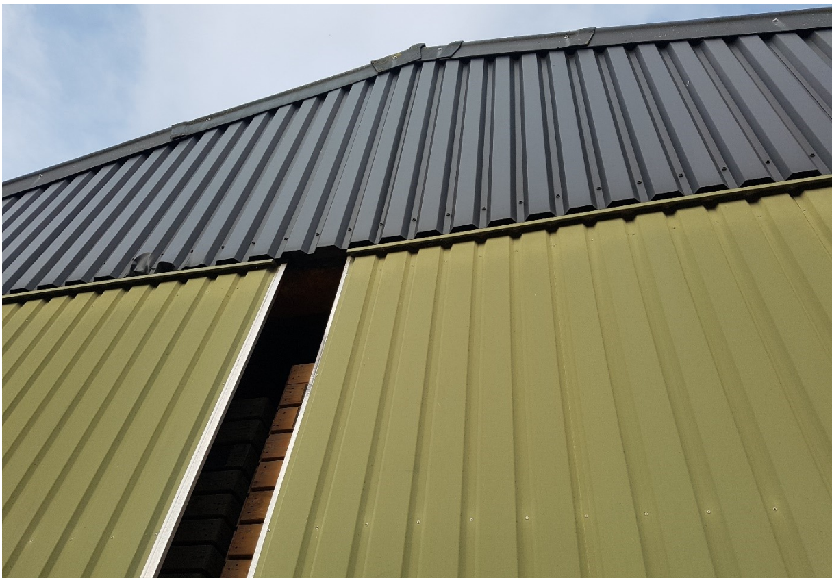
De derde loods biedt aan de buitenzijde geen ruimte aan vleermuizen
