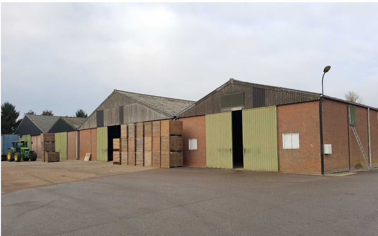
De vier loodsen die zullen worden gesloopt.
