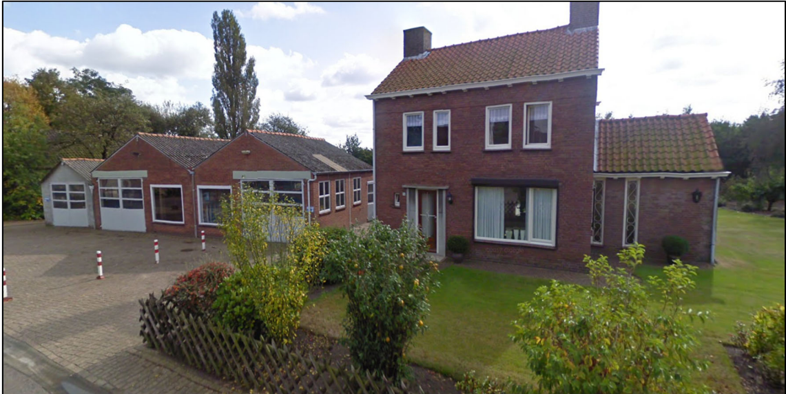
Foto van het plangebied vanaf Welbergsedijk; links de bebouwing van het te slopen garagebedrijf, rechts de bedrijfswoning die behouden blijft (Cyclomedia)
