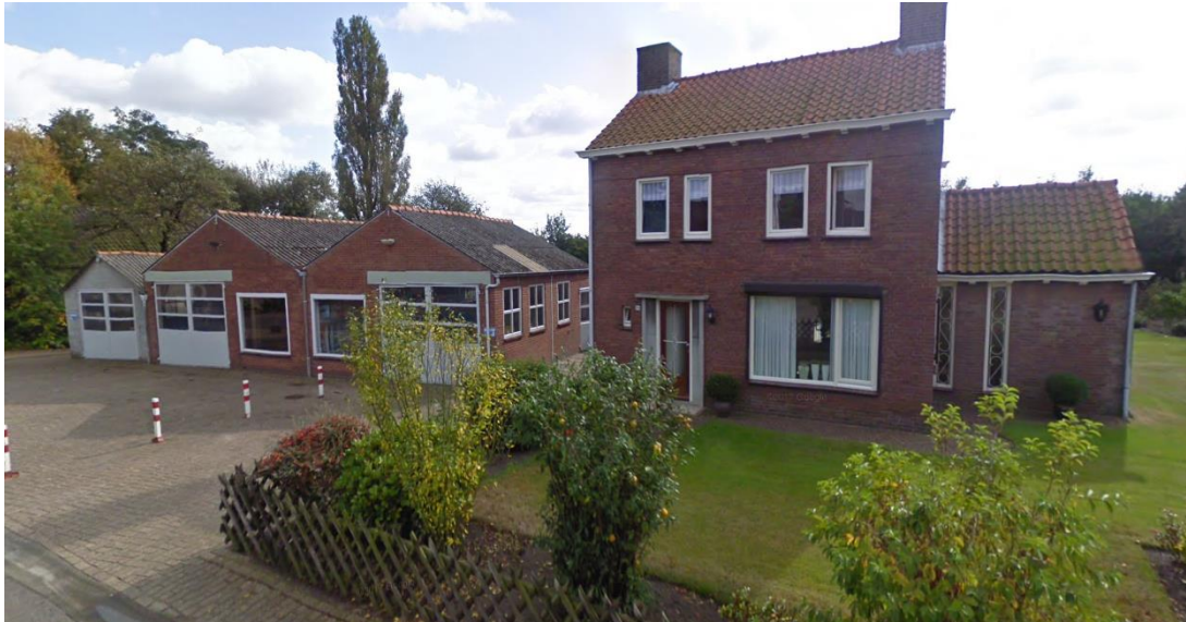
Figuur 2.3: Foto onderzoekslocatie
