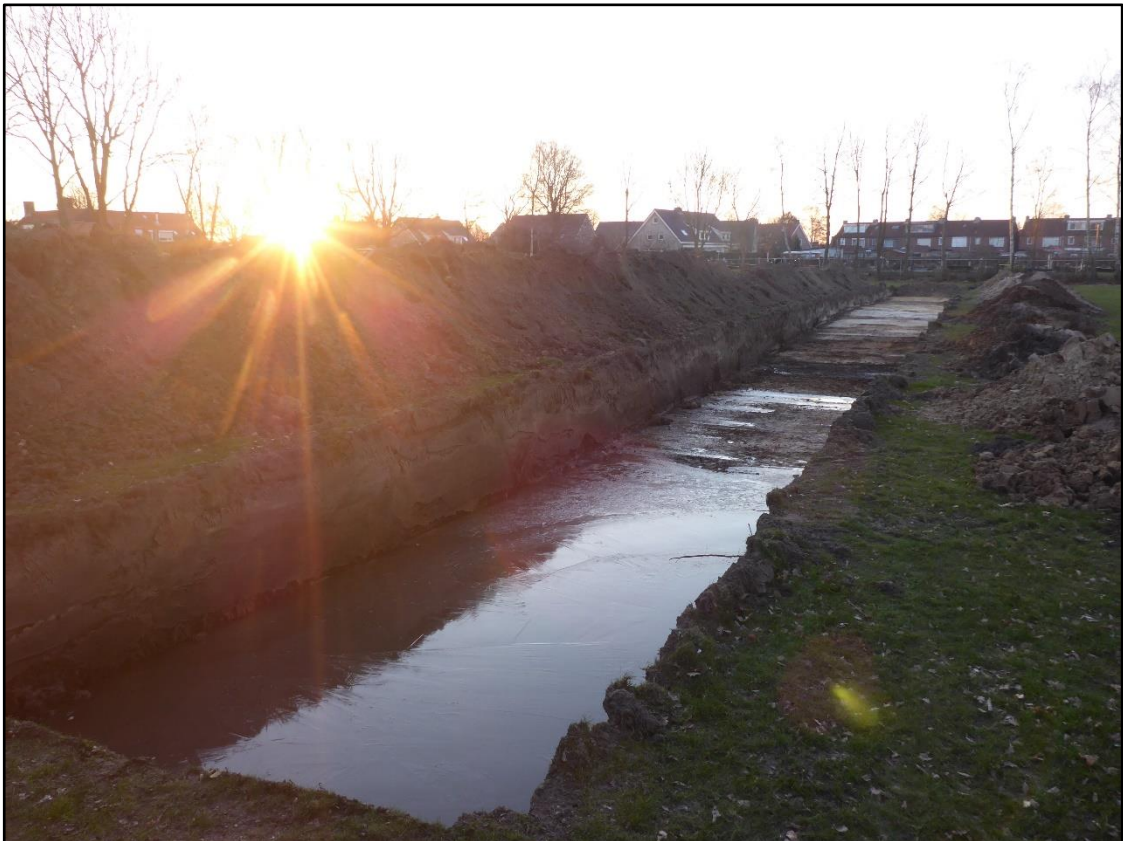
Figuur 5. Het noordelijke deel van de werkputten stroomde tijdens de aanleg van het vlak al snel onder water. Bij aankomst in de ochtend na de aanleg van de vorige dag stond er een diepe plas grondwater in de putten.
