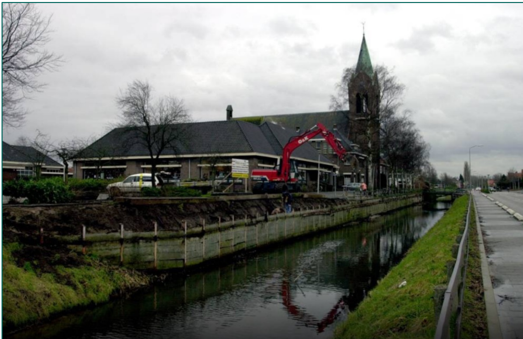
Figuur 7: Vervangen kadeconstructie (bron: www.bndestem.nl ).
